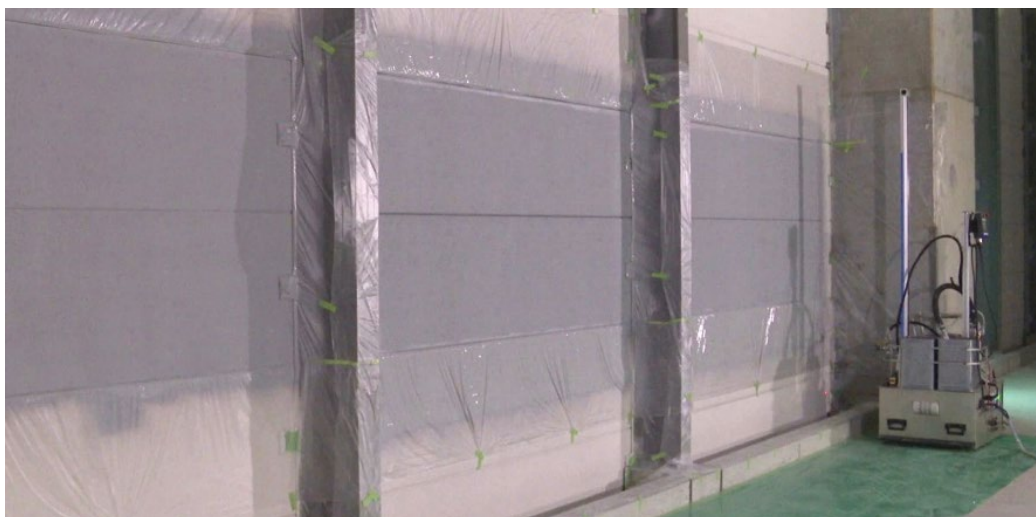
壁面吹付塗装ロボットによる施工状況
