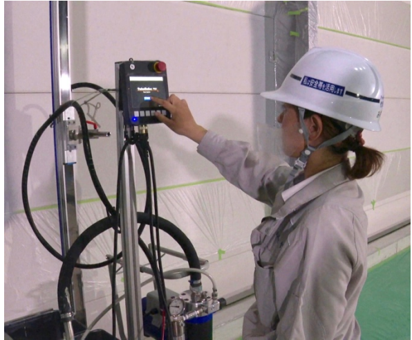
ロボットへの作業指示状況
